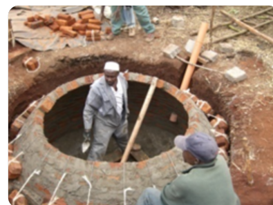
Bau von Biogasanlagen für Haushalte in Kenia
